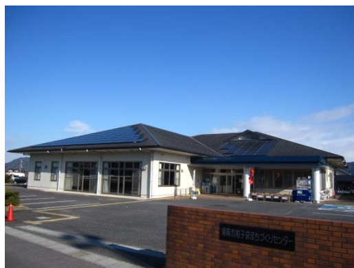
四号機設置場所 (柑子袋まちづくりセンター)
