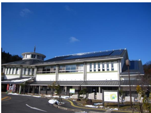
参号機設置場所 (十二坊温泉ゆらら)
