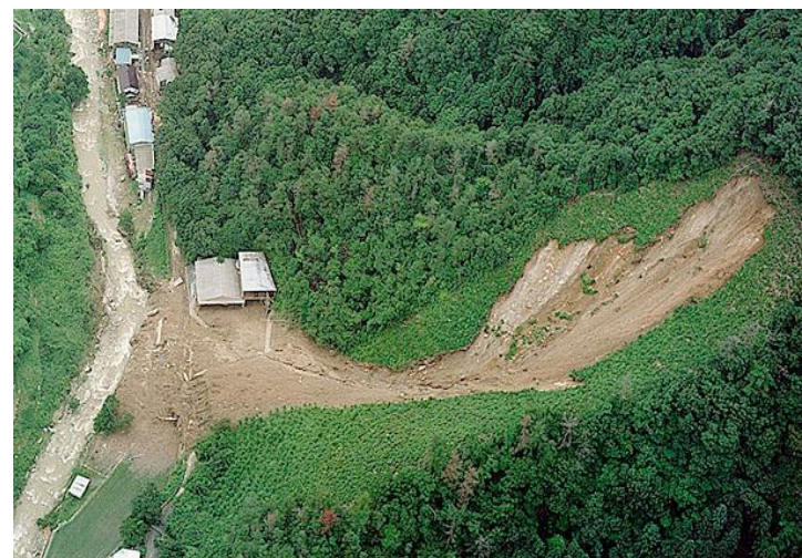
1999年6月広島豪雨における表層崩壊 アジア航測ホームページによる
